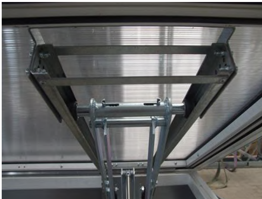
Rys. 25 Połączenie układu otwierającego prod. ACTULUX ze skrzydłem klapy oddymiającej mcr PROLIGHT.
